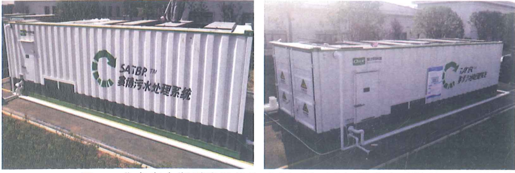
图 4-2 北京安力斯测试运行前（左）后（右）设备表面情况
